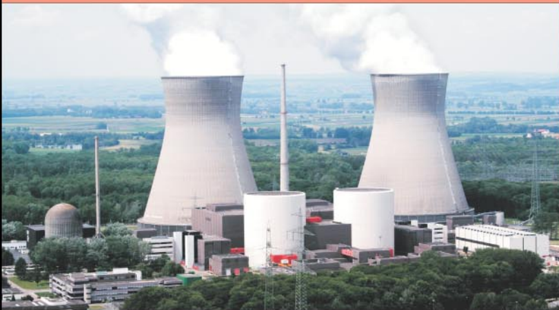
AKW-Gundremmingen mit Kühltürmen und Atommüll-Lager Im Vordergrund Reaktor A, B und C. Das Zwischenlager für Atommüll (Halle rechts) bietet für 192 Castoren lediglich Wind- und Wetterschutz.
