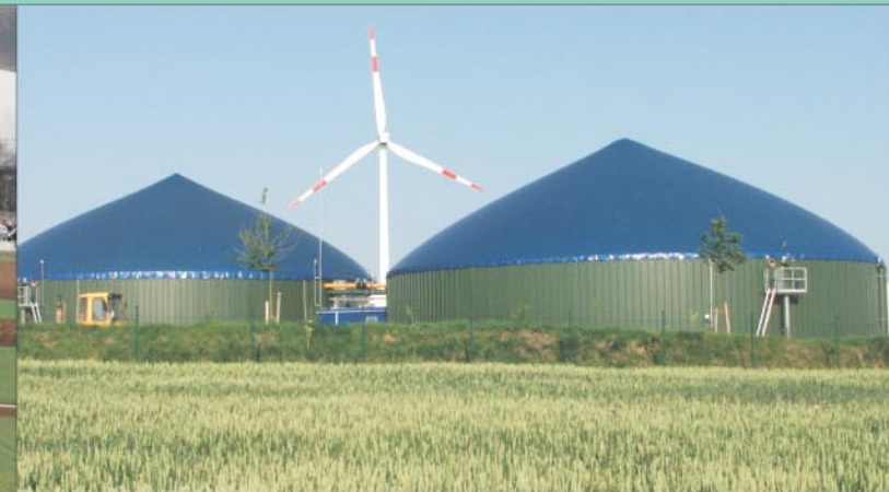
Biogasanlage, im Hintergrund Windkraftanlage Seligweiler.
